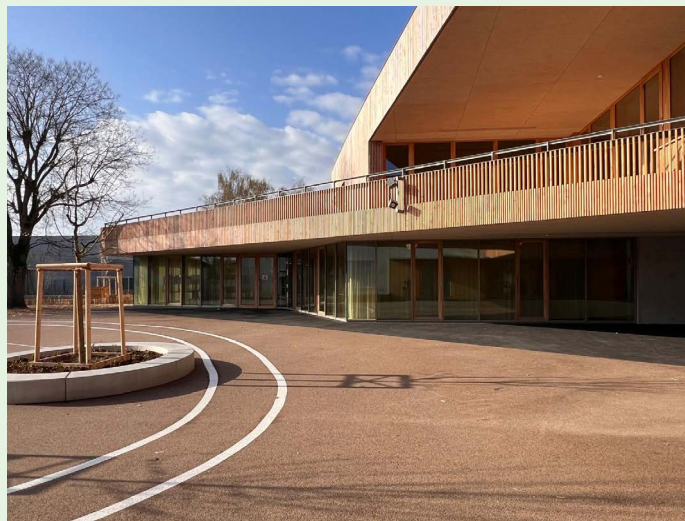
Accès vers le 1 er étage
