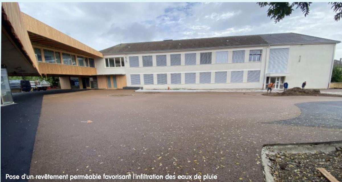
Pose d'un revêtement perméable favorisant l'infiltration des eaux de pluie
